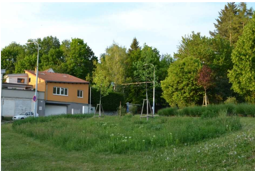
Obr. 24 Objekt č. 2 – Vzdálený pohled od ulice Chaloupky. 16.5.2022. FOTO: Autor
