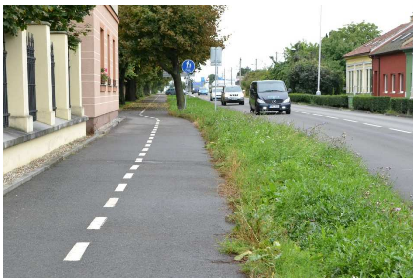
Obr. 177 Objekt č. 8 – 15.9.2022. FOTO: Autor
