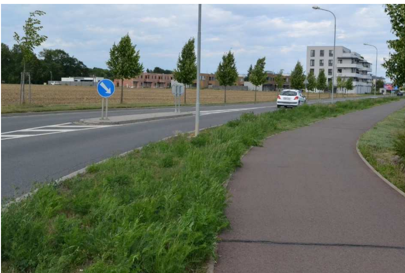
Obr. 151 Objekt č. 7 – Pohled na obnovený porost. 17.7.2022. FOTO: Autor
