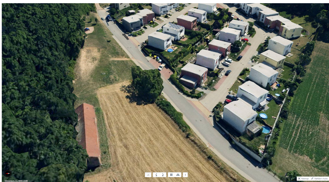
Obrázek 13-4 – 3D pohled na budoucí staveniště č. 2 (zdroj: mapy.cz)
