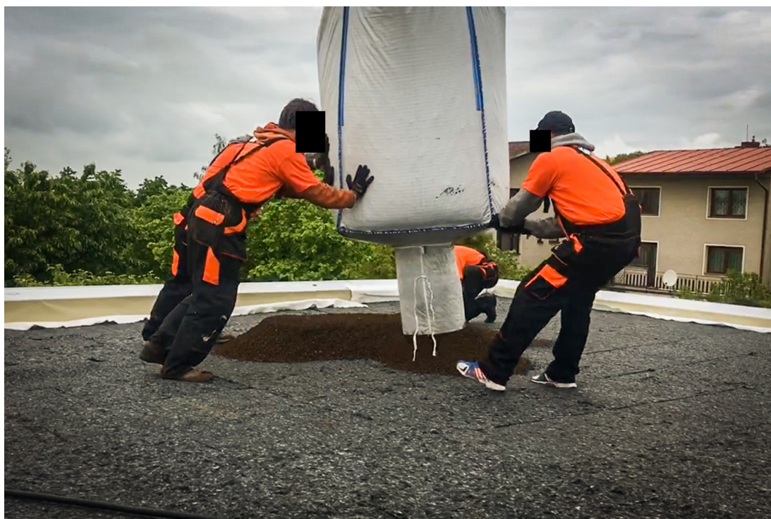
Obrázek 10-3 - pokládání substrátu (zdroj: archiv firmy Smart Roof Solutions)
