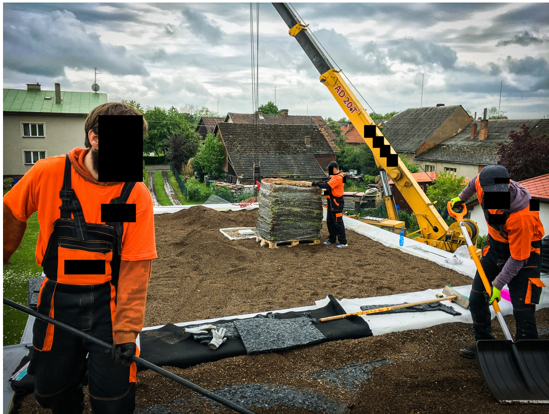
Obrázek 10-5 - rozhrabování vegetační vrstvy – substrátu (zdroj: archiv firmy Smart Roof Solutions)
