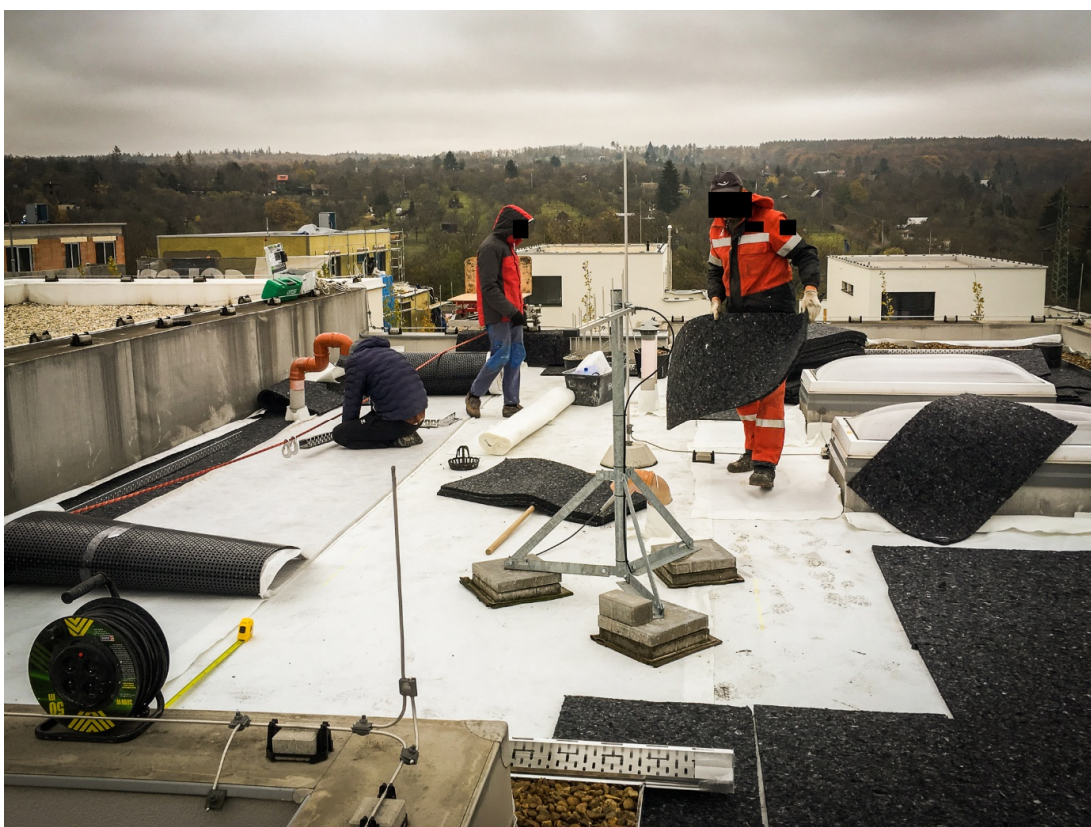
Obrázek 10-2 - položení polyesterové desky EnviBoard (zdroj: archiv firmy Smart Roof Solutions)
