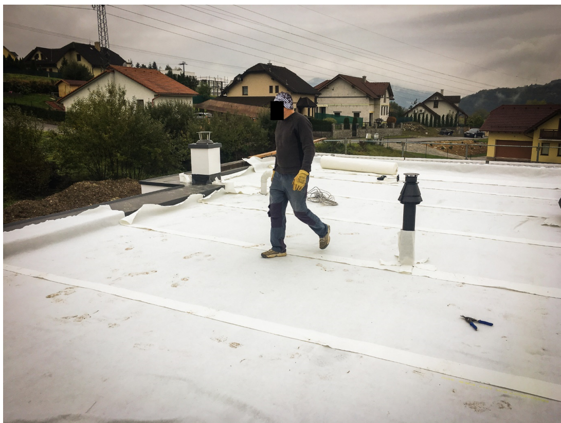
Obrázek 10-1 - položení geotextílie (zdroj: archiv firmy Smart Roof Solutions)
