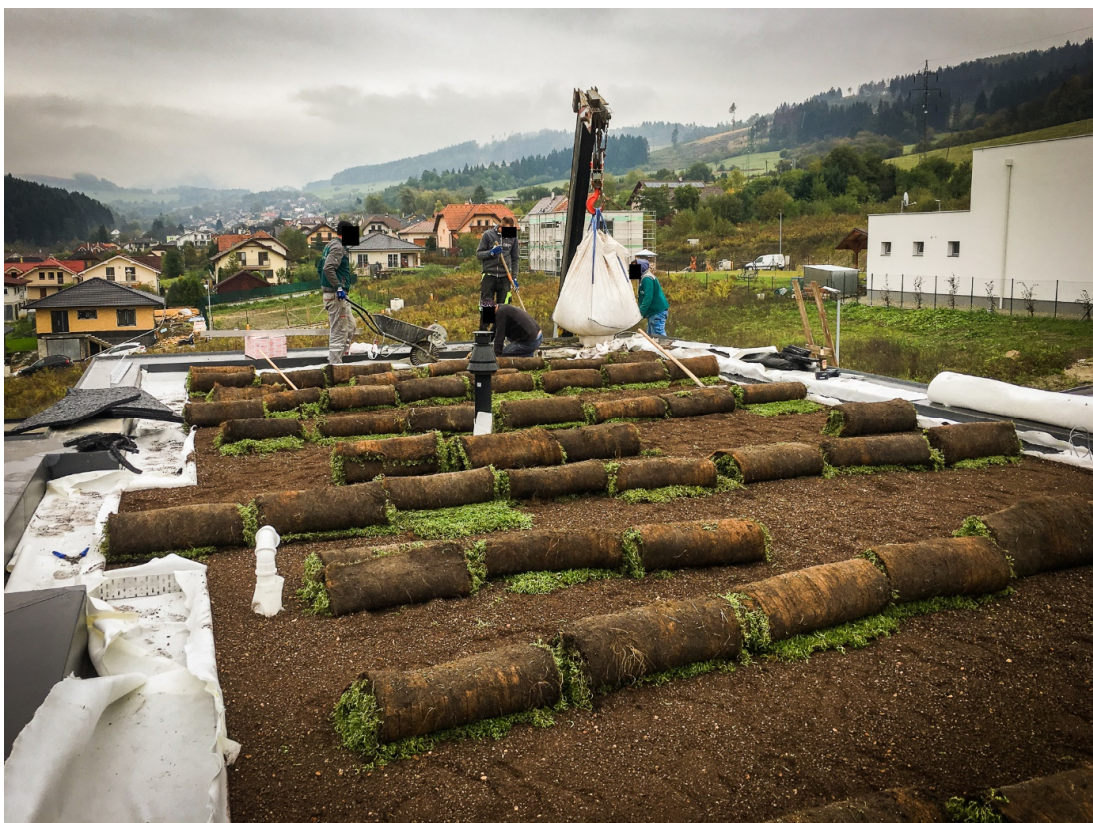
Obrázek 10-4 - pokládka vegetace (zdroj: archiv firmy Smart Roof Solutions)
