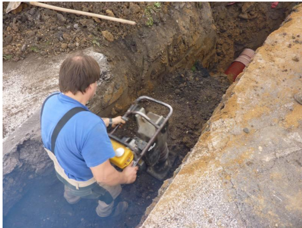
Obr. 8 – Mechanická úprava zeminy [36]
